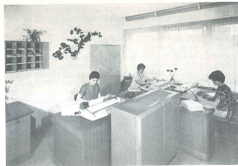
Bild 1. Zur rationellen Auslastung des elektronischen Multipliziergerätes können bis zu 3 Buchungsmaschinen gleichzeitig arbeiten
