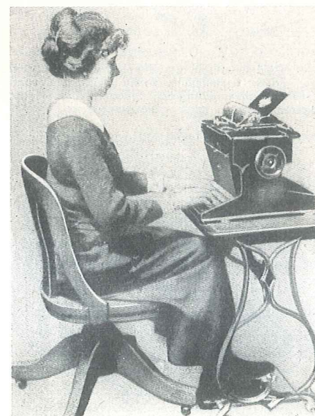
Bild 2. Schreibmaschine mit Fußschaltung um 1875
