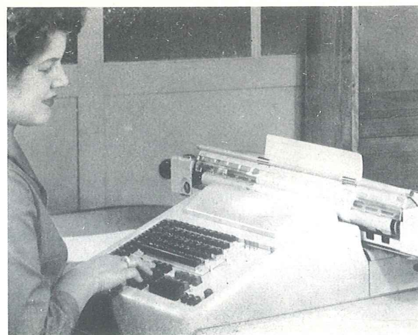
Bild 1. ASCOTA-Buchungsautomat Klasse 170 mit Zehnertastatur, Kurztext und Volltext
