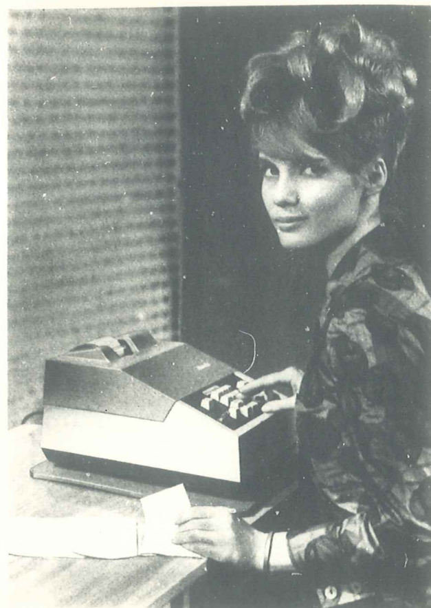
Bilder 3 und 4. Die druckende Dreispeziesmaschine ASCOTA Klasse 114 multipliziert nach einer verkürzten Methode
